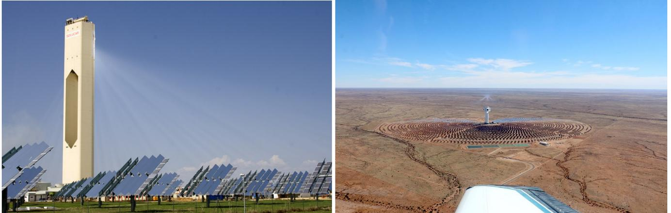
**Figuras: 1a)** La planta de energía solar PS10 en Andalucía, España, concentra la luz solar de un campo de heliostatos en una torre central de energía solar. **2b)** Concentradores solares de Khi Solar One, Sudáfrica.
