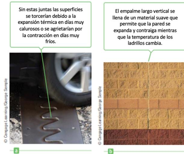
Sin estas juntas las superficies se torcerían debido a la expansión térmica en días muy calurosos o se agrietarían por la contracción en días muy fríos.
